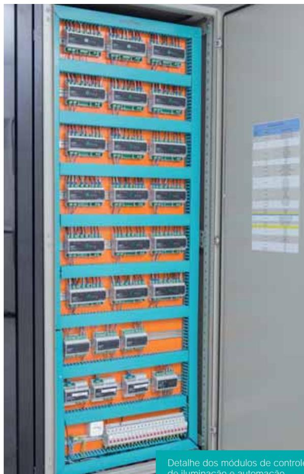
Detalhe dos módulos de controle de iluminação e automação
