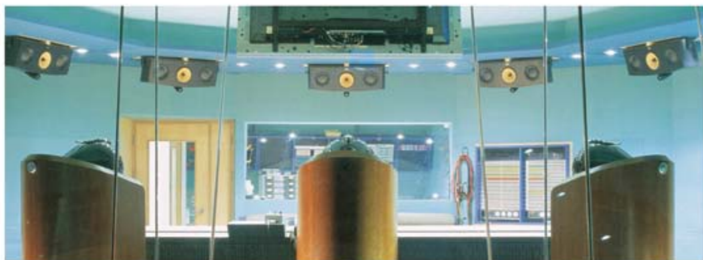
Sala de controle do Estúdio 1, com três caixas frontais B&W 800 Diamond, cinco caixas surround B&W HTM1 e 11 amplificadores Classé CAM-400
